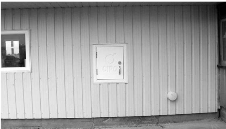
Le portail de réception de semence permet au livreur de déposer le colis dans l'appareil de conservation sans avoir à pénétrer dans le bâtiment d'élevage.
